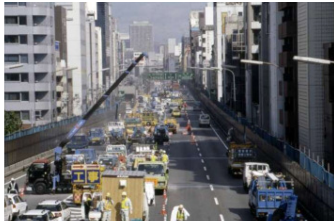
2002年の終日通行止め工事の様子
