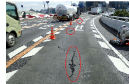
舗装の損傷
