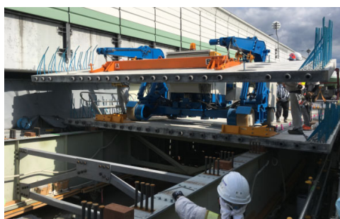
平板型 UFC 床版の架設
