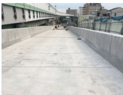
玉出施工完了
