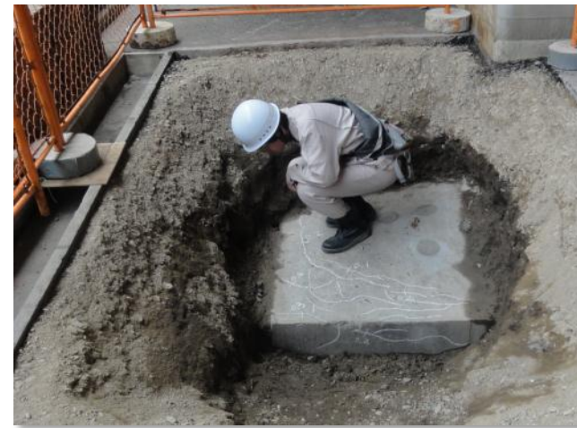
A S R橋脚 基礎調査
