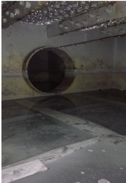
湊町鋼製 フーチング 内部状況調査
