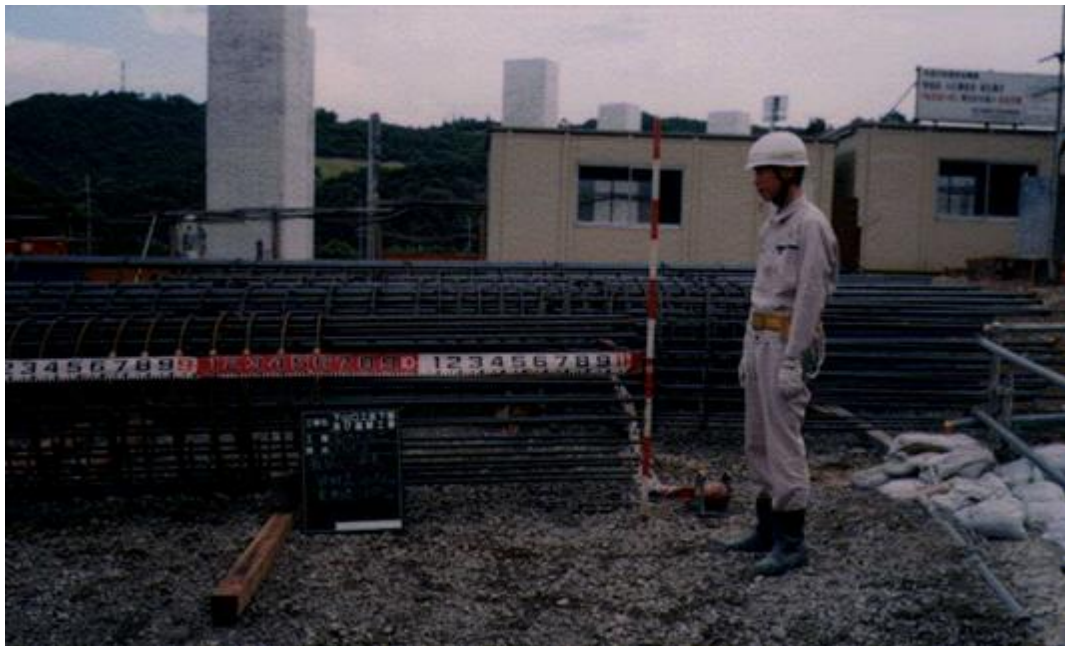
鉄筋かご実長の接写の例
