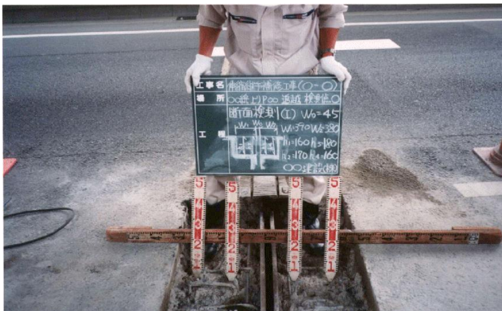
伸縮継手切削断面の計測
