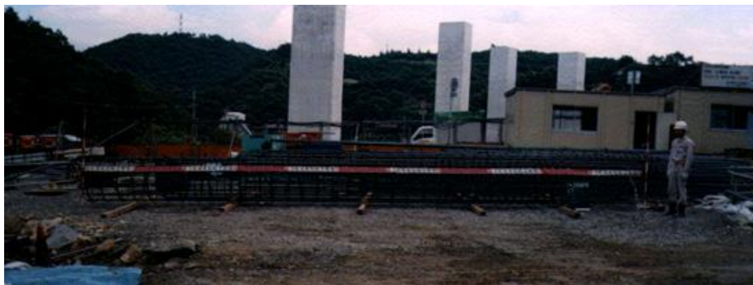
鉄筋かごの実長の全景の例
