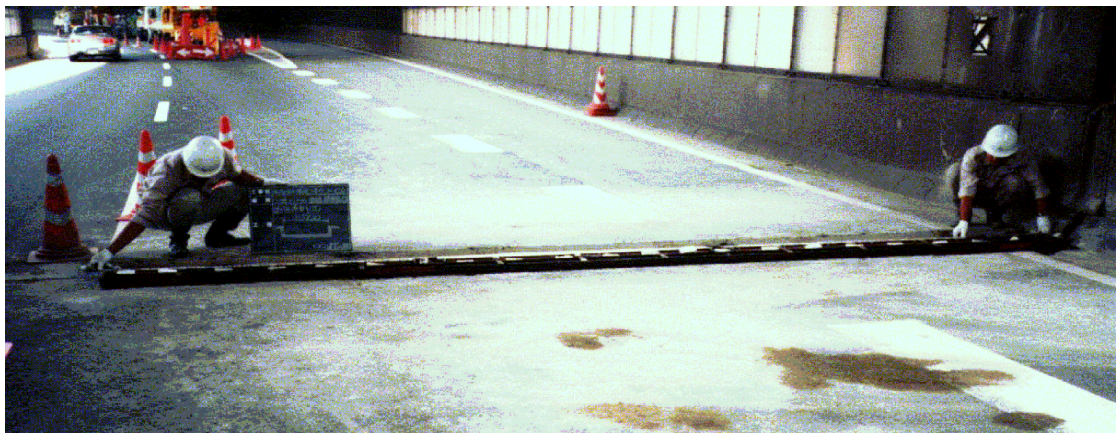
伸縮継手補修実長の全景の例
