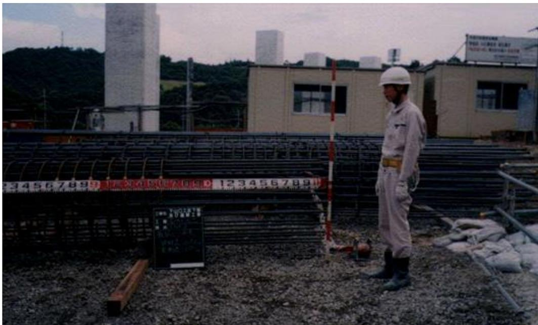
鉄筋かご実長の接写の例
