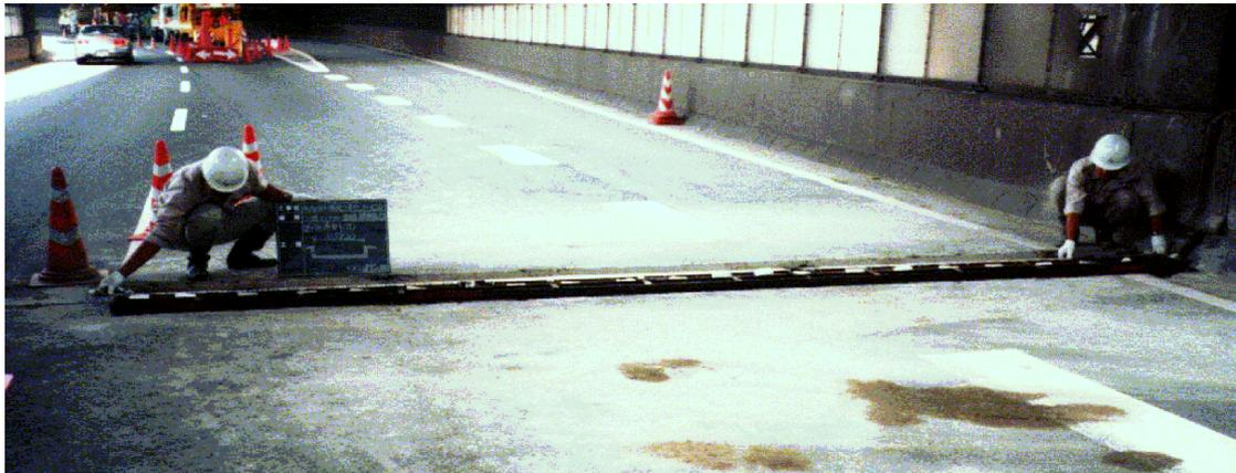
伸縮継手補修実長の全景の例
