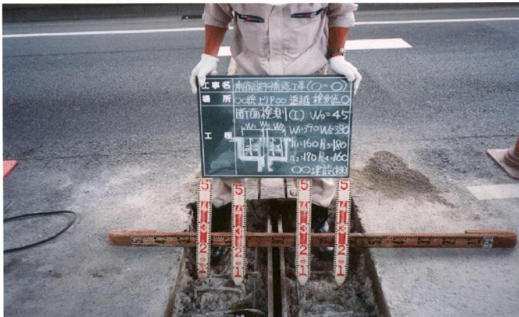
伸縮継手切削断面の計測
