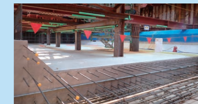
トンネル函体工(駒栄地区)
