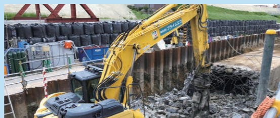
地中障害物撤去工事(豊崎地区)
