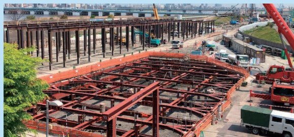
換気所および開削トンネル掘削工(海老江地区)
