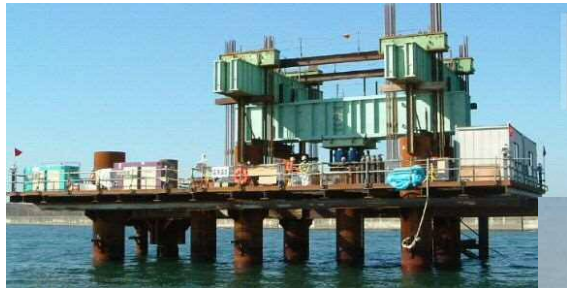
図-1. 国内最大規模の静的載荷試験 (東京ゲートブリッジ: 鋼管杭径1,500mm)
