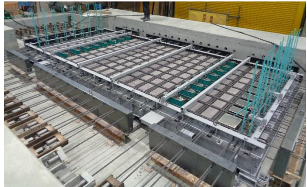
ワッフル型 UFC 床版用の型枠
