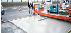
SFRC施工状況
