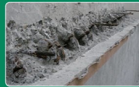
コンクリート内部の破断した鉄筋
