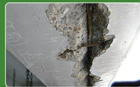
ケーブル腐食の影響で発生したコンクリート桁下面の剥離
