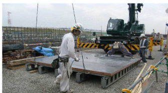
ステンレスパネル大型枠 再利用可能な材料の使用
