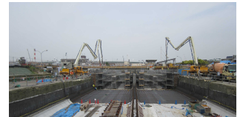
土留支保工を削減した施工
