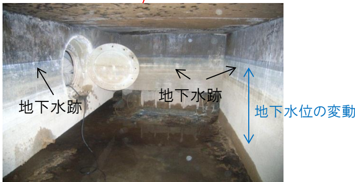
鋼製フーチング内部
