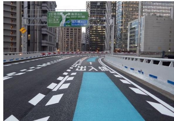
写真-6 中之島JCT～出入橋出口間におけるカラー舗装設置状況
