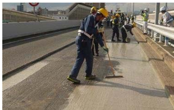
(2) 浸透型防水材 2 層目
