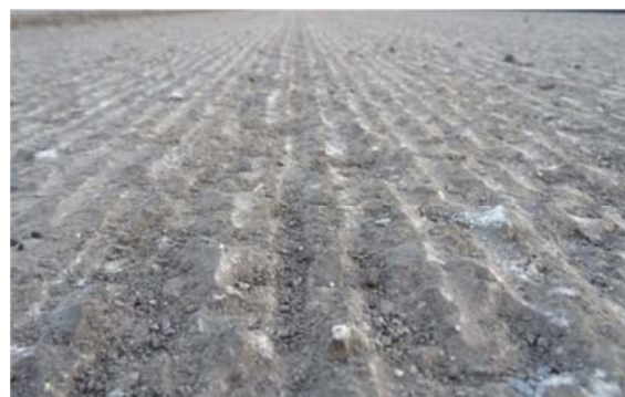
写真-1 舗装撤去後のRC床版上面
