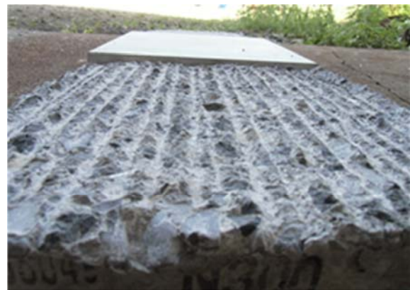
写真-2 切削後のコンクリート板
