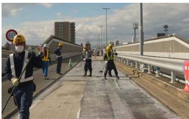
(1) 浸透型防水材 1 層目
