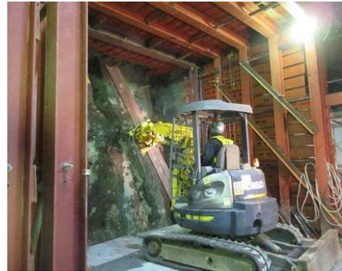
写真-2 導坑支保工の建込み状況
