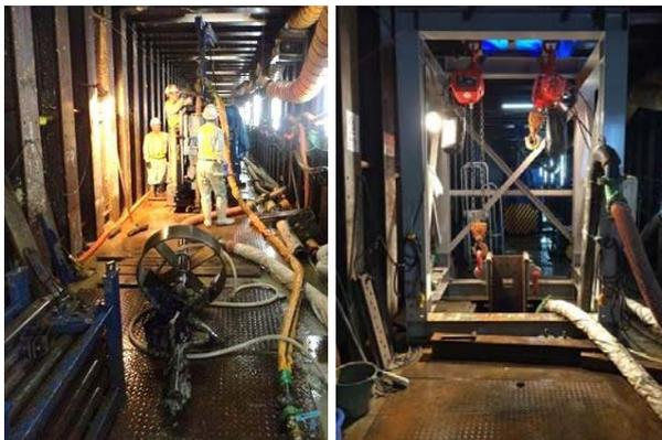
写真-3 BH工法削孔(左)と芯材建て込み(右)
