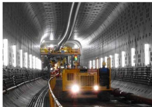
写真-6 矩形シールド施工状況
