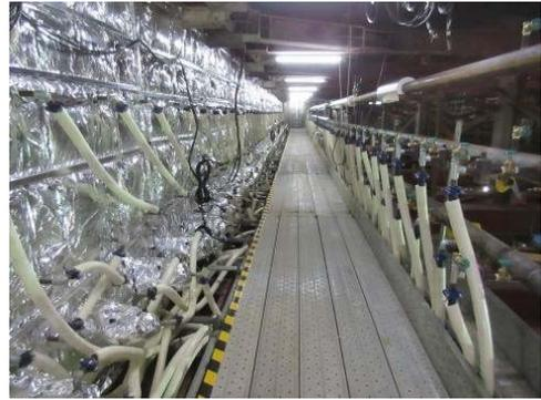
写真-1 凍結管の設置状況
