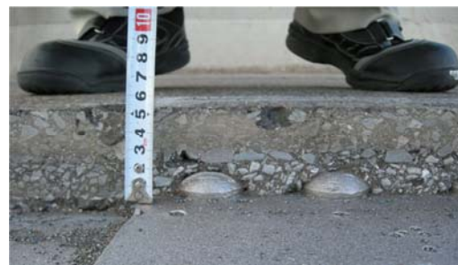
図-6 ボルト頭部上の舗装状況 (鋼床版デッキプレート上)
