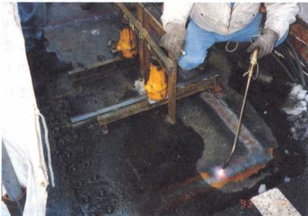
写真-1 線状加熱によるひずみ取り
