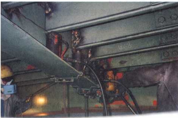
写真-2 下方からのジャッキアップ
