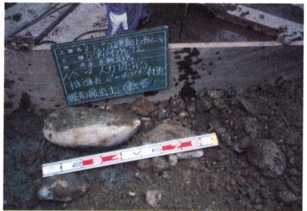
写真-1 玉石の状況
