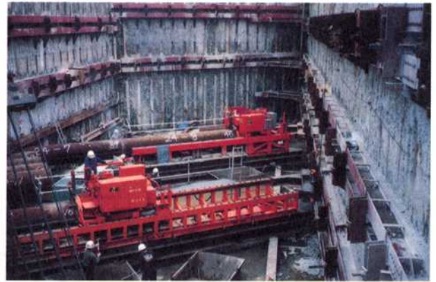
写真-2 水平パイプルーフ施工状況
