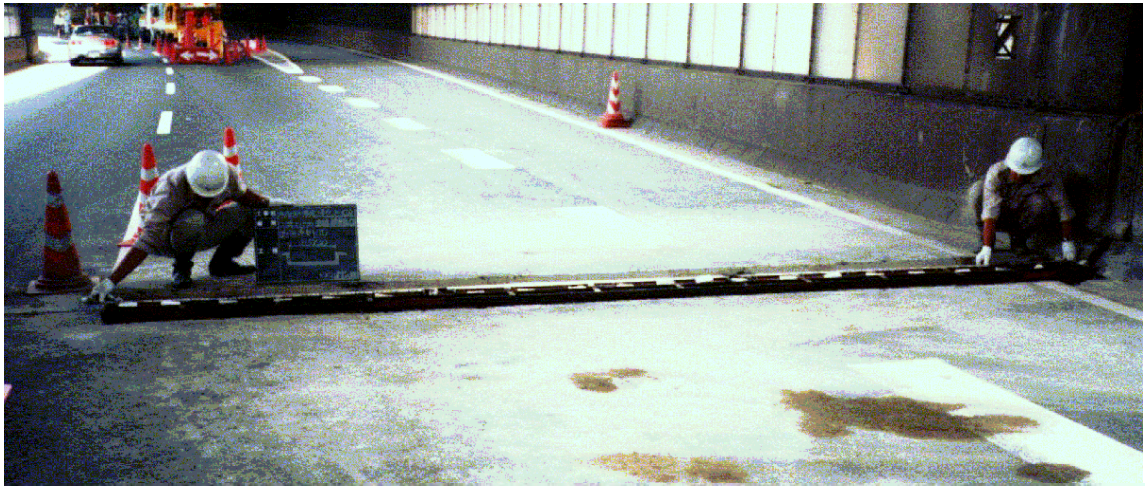
伸縮継手補修実長の全景の例
