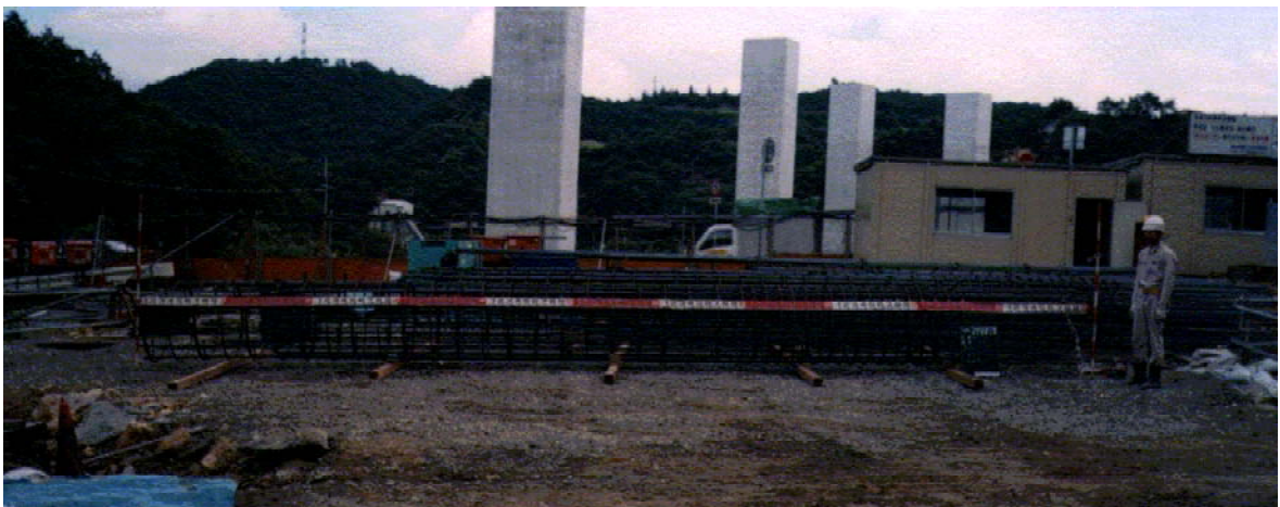
鉄筋かごの実長の全景の例
