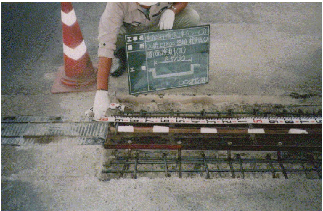
伸縮継手補修実長の接写の例
