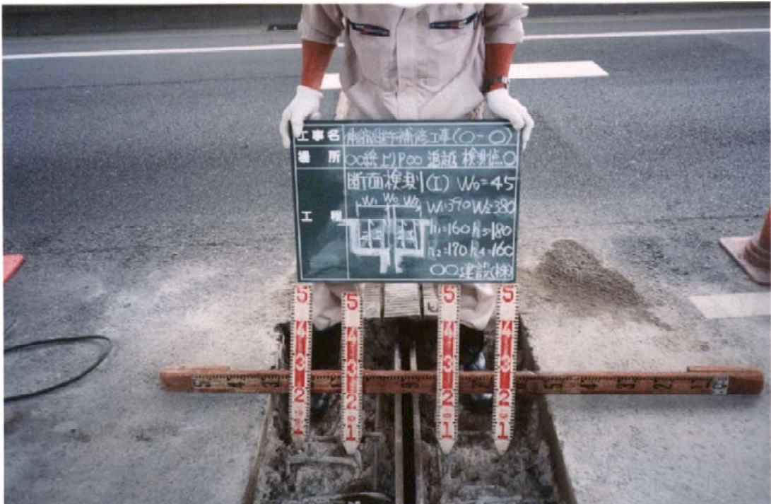
伸縮継手切削断面の計測
