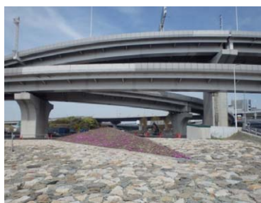
桁高と桁色の連続性などに配慮した構造物
