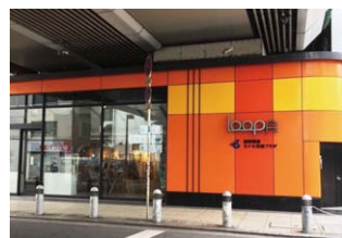
Loop A(1号環状線四ツ橋入口付近の高架下)の外観
