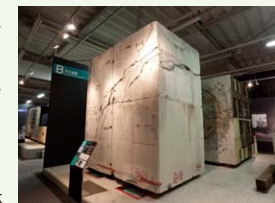
被災した橋脚の展示
